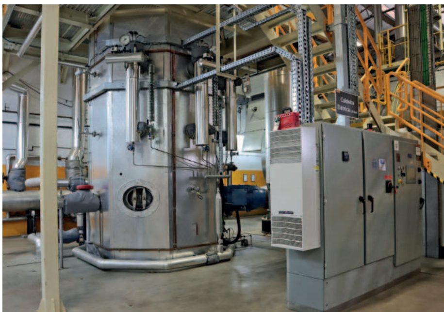
Dieser Elektrokessel in der Reifenproduktion in Lousado von Continental kann Dampf aus Ökostrom statt aus Erdgas erzeugen. So wird CO 2 -neutral produziert.
