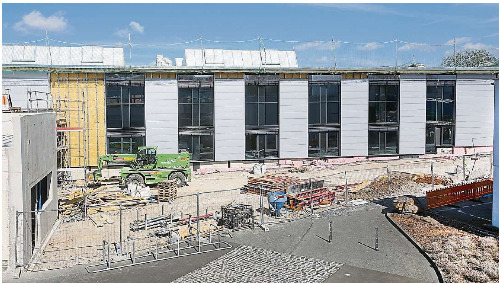
In der noch im Bau befindlichen Produktionshalle der Firma baier & michels soll Ende des Jahres die Produktion aufgenommen werden.
